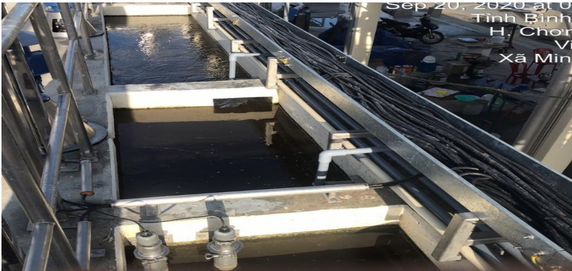
Hình 5. Cụm bể keo tụ - tạo bông giai đoạn 2
