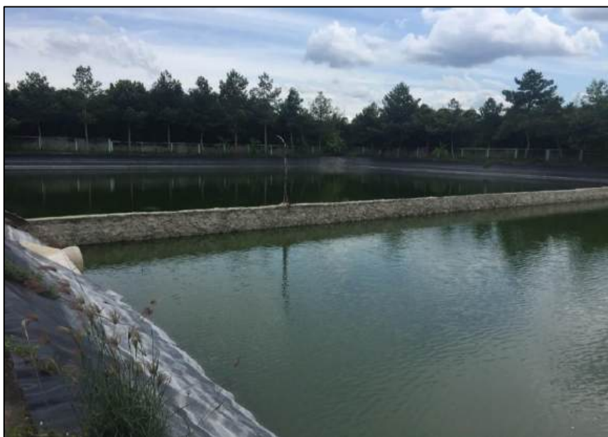
Hình 7. Hồ sự cố hệ thống xử lý nước thải
